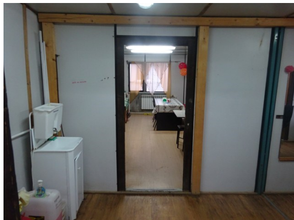
Здание мастерской лит.В (внутреннее помещение)
