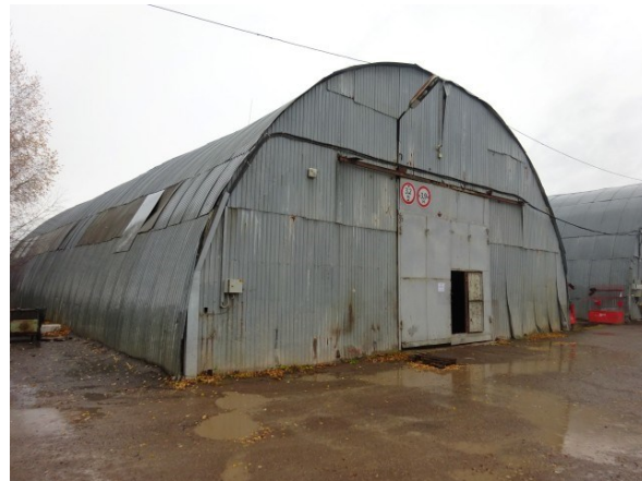
Склад № 2 арочный (Литера З)
