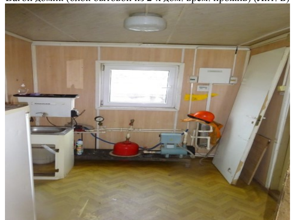
Внут. помещение вагон домик (Лит. Б)
