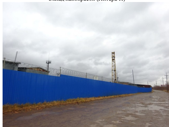
Окружающая застрока и подъездные пути
