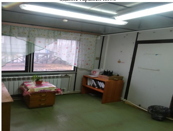
Здание гаражей лит.Г (внутреннее помещение)
