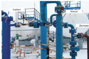
Гидроциклон + сетка + графит
